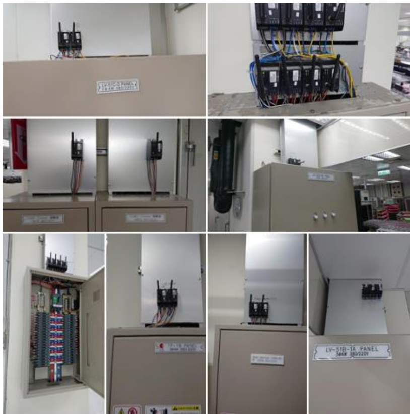
在各個配電盤加裝智慧電表，完整收集廠內能源使用數據
